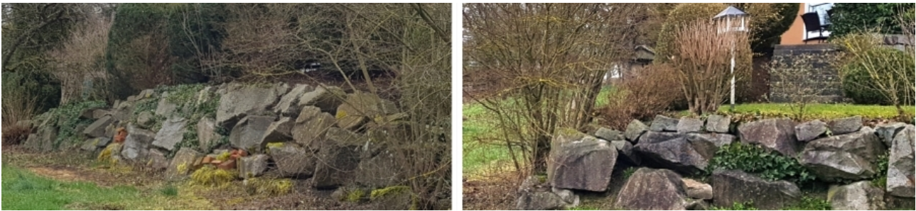
Abbildung 13: Ansichten der Trockenmauer: Nordwest-exponierter Bereich (links) und Richtung Südwesten ausgerichtetes Teilstück. Beide Aufnahmen vom 12.03.2024).
